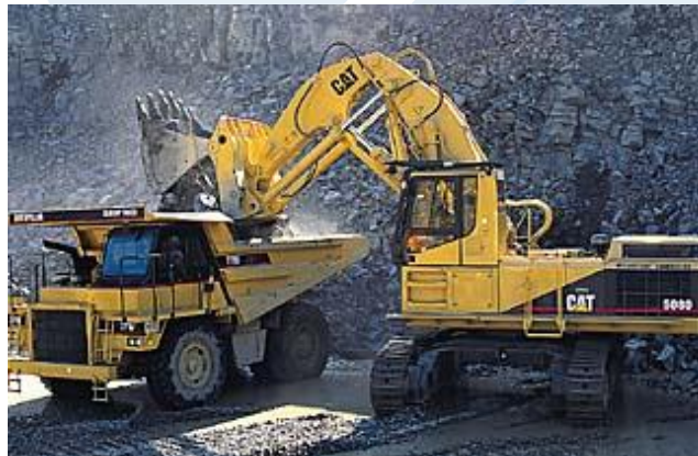
Dump Truck dan Excavator
